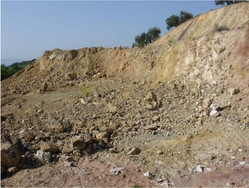
Foto 1; desmonte en el P.K. 0+400.
