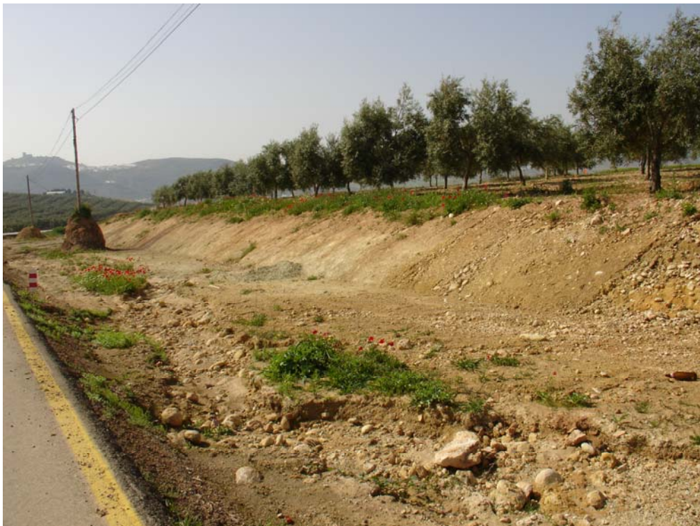
Foto 4; desmonte en el P.K. 2+200.
