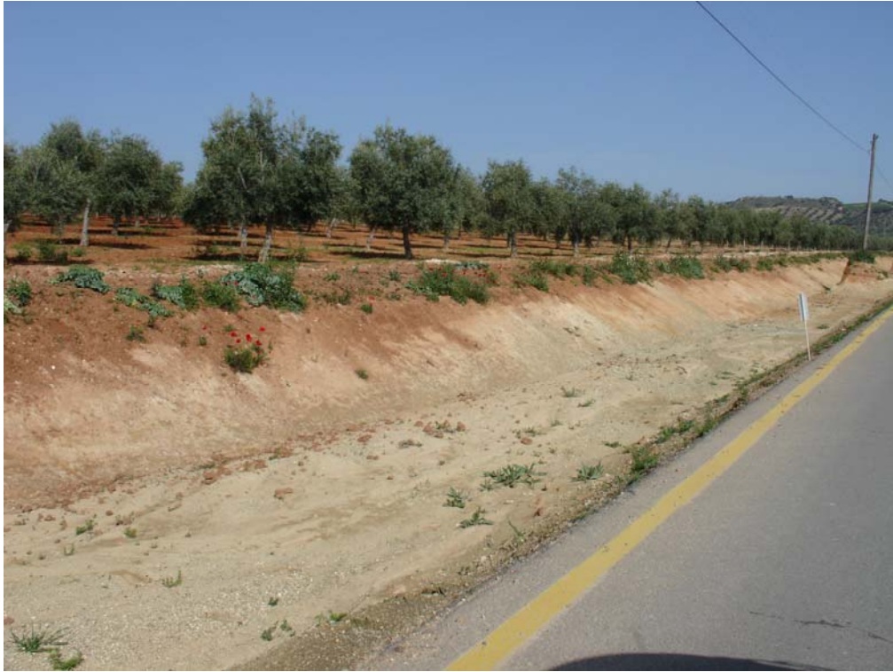
Foto 3; desmonte en el P.K. 2+100.
