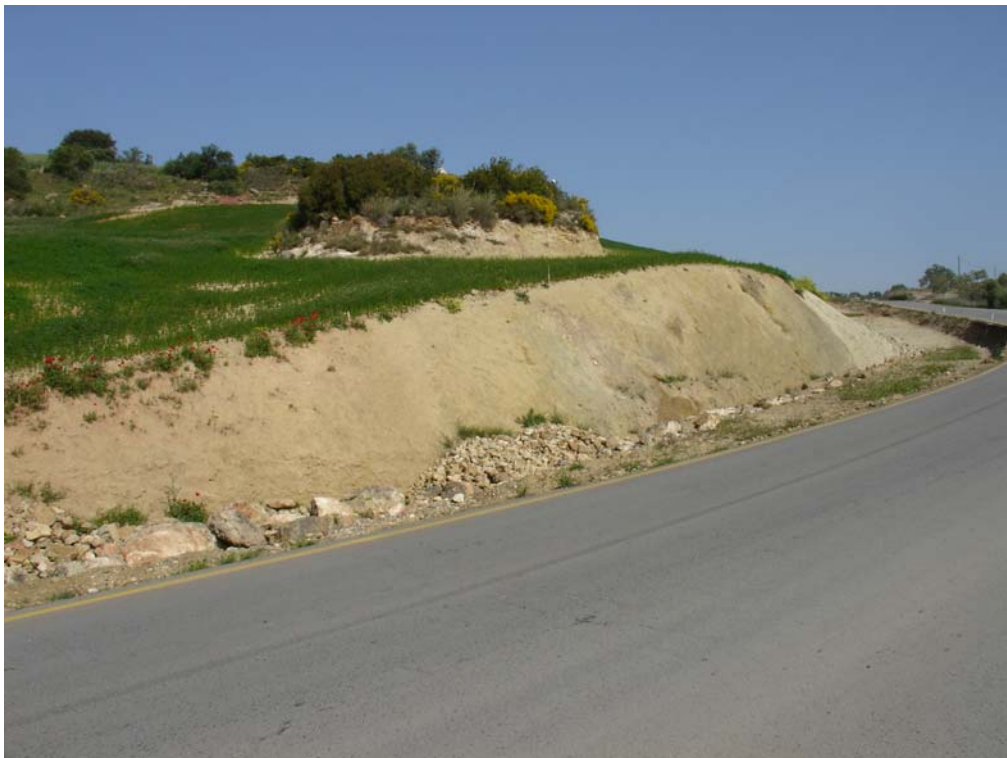
Foto 2; desmonte en el P.K. 0+900.
