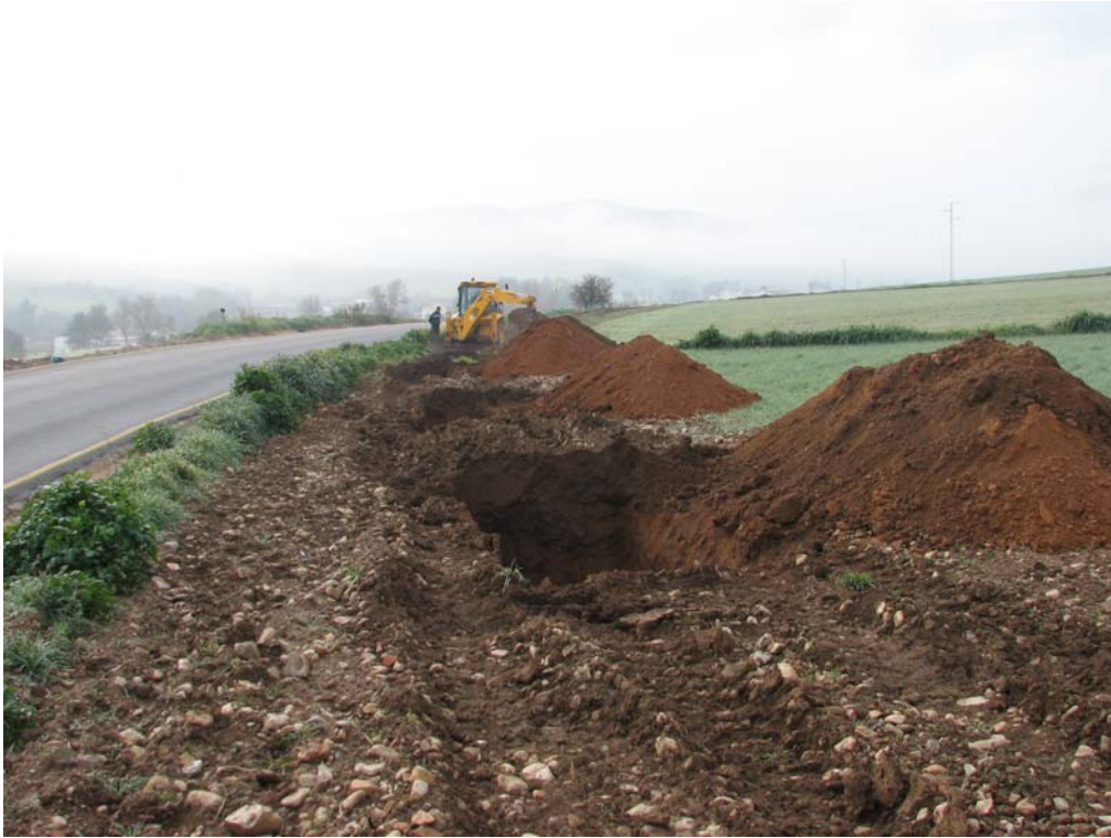
Foto 5; vista desde el norte de la zona arqueológica protegida durante la ejecución de las zanjas.
