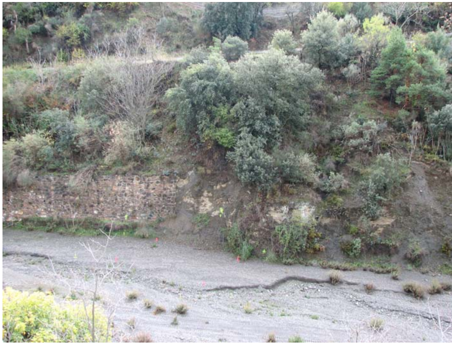
Zona de afección por la Estructura E7 y el Muro ESC 19 (Barranco del Lagarto).
