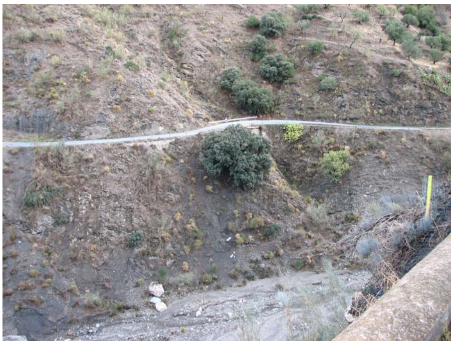
Zona de afección por la Estructura E1 y el Muro ESC 1 (Barranco de la Barbacana).
